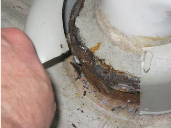
Figur 2-6 Eksempel på termokit anvendt ved støbejernsmuffe for toilet udført 1970. 185
