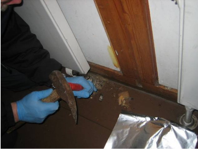
Figur 2-5 Eksempel på udtagning af linoleum og undergulv for undersøgelse af PCB-indhold 184
