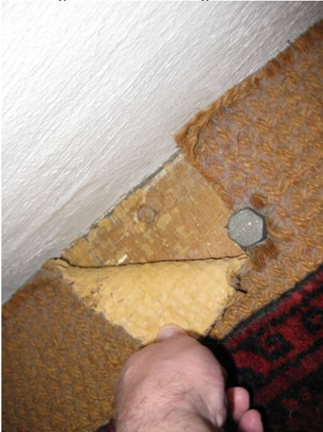
Figur 2-4 Eksempel på kokostæppe fra 1970 med DDT-forurenet naturgummi bagbeklædning limet på bræddegulv med PCB-holdig kontaklim konstateret i Danmark i forbindelse med reovering af gulv 183
